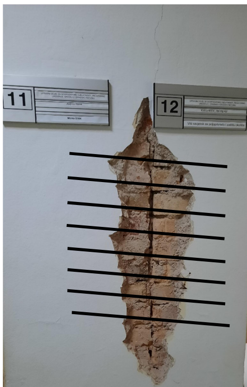
Slika 33. Preklopljene sljubnice koje se saniraju
