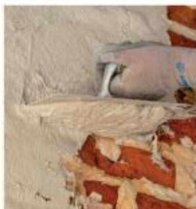
Žbukanje reparaturnim mortom
