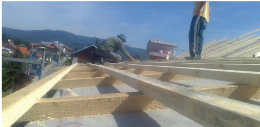
Slika 36. Letve i kontraletve na foliji
