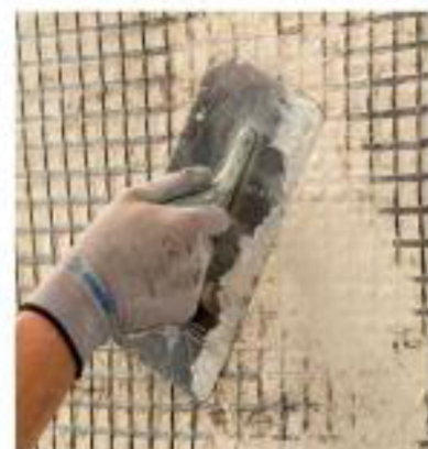
Ugradnja FRCM sustava
