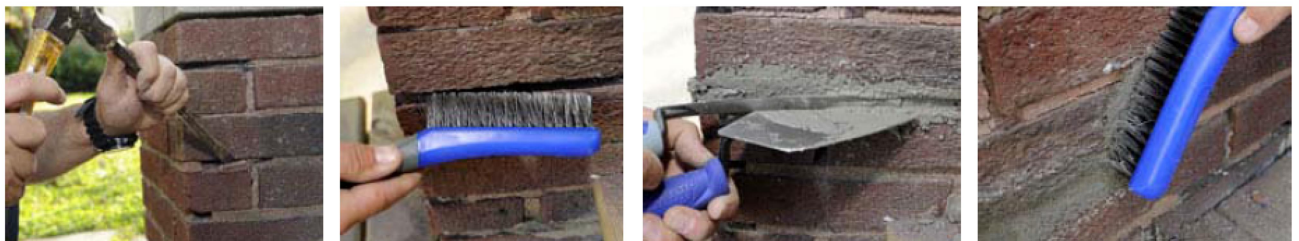
Slika 24. Djelomična zamjena morta u sljubnicama
